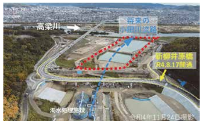
新合流点付近の進捗状況
