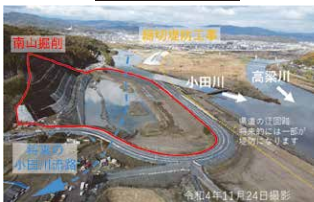
南山付近の進捗状況
