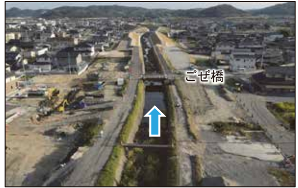
ごぜ橋周辺の進捗状況 (令和4年11月撮影)
