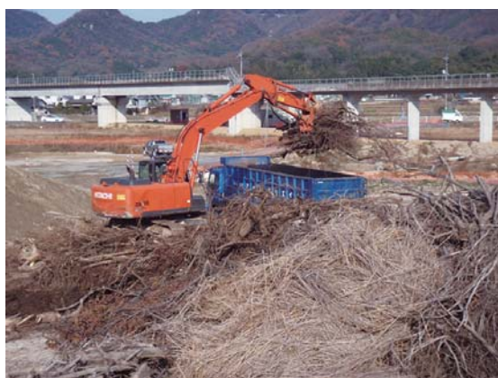
伐木搬出状況【伐木積込機械：(左)バケットホーク仕様、(右)ピラニアバケット仕様】
