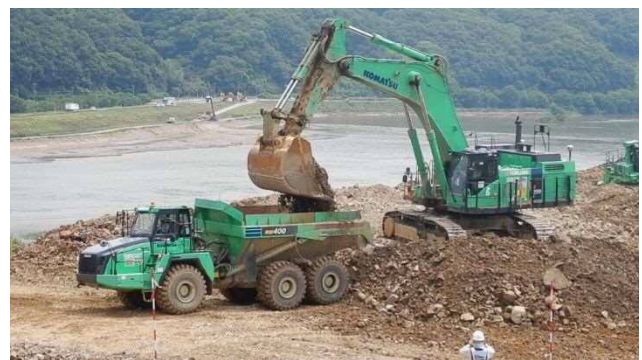
南山掘削状況
