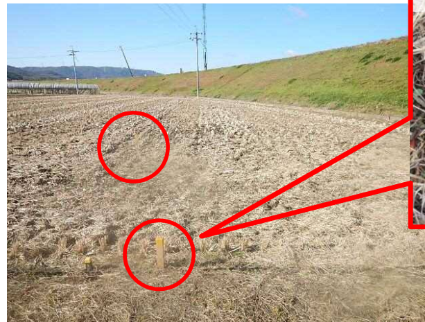
用地幅杭の設置(用地取得範囲の目印)
