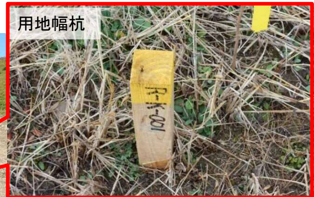
用地幅杭の設置(用地取得範囲の目印)
