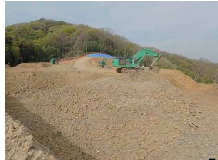
令和2年4月 南山山頂の掘削を実施中
