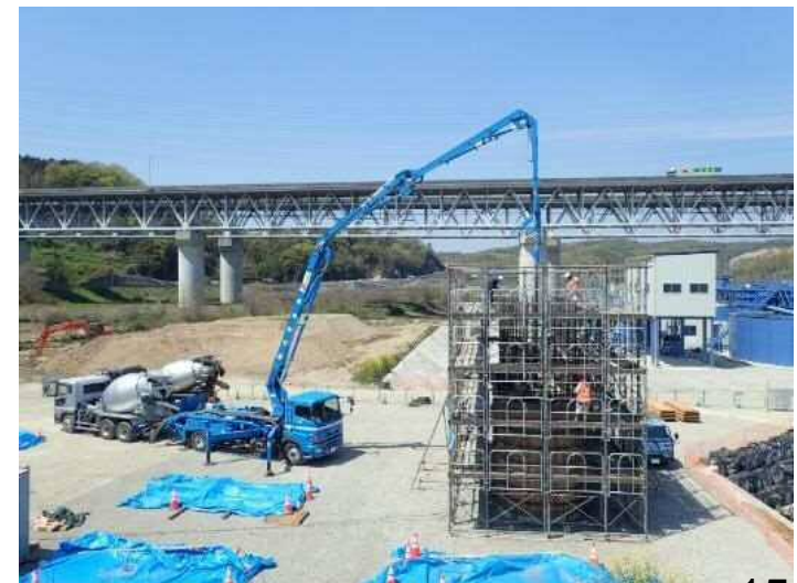
令和2年4月 橋脚コンクリート工事中
