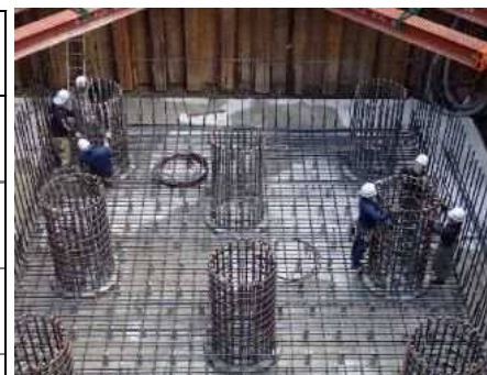
橋脚鉄筋組立
