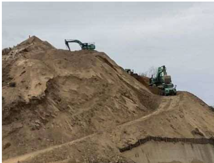
令和2年1月23日に本格的な掘削に着手
