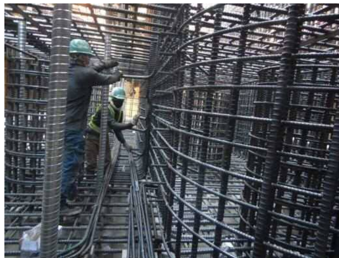
令和2年1月 橋脚の鉄筋組立
