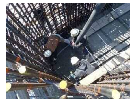
橋脚コンクリート打設
