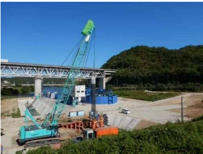
令和元年10月 橋脚の基礎杭工事
