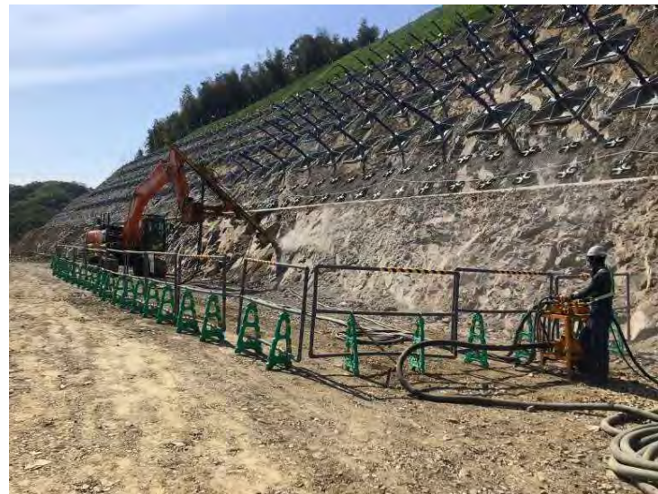
令和3年4月 南山法面保護
