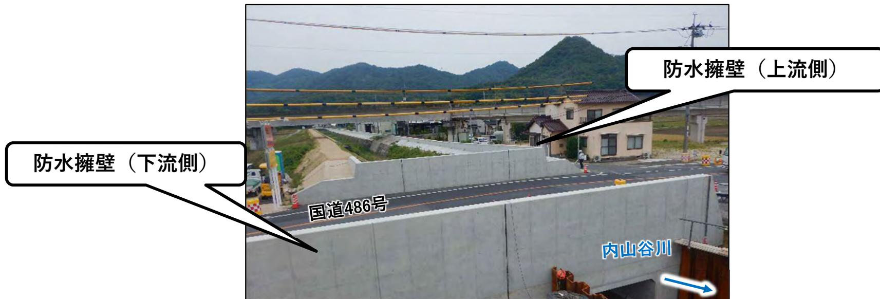
施工状況（令和3年6月2日 時点の状況）
