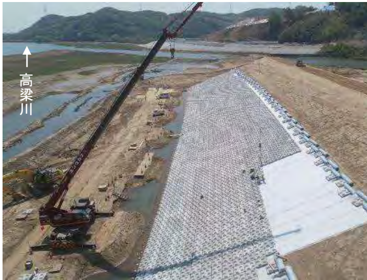
令和2年4月 締切堤防の護岸設置
