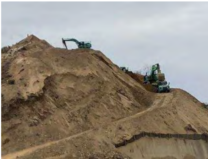
令和2年1月23日に本格的な掘削に着手
