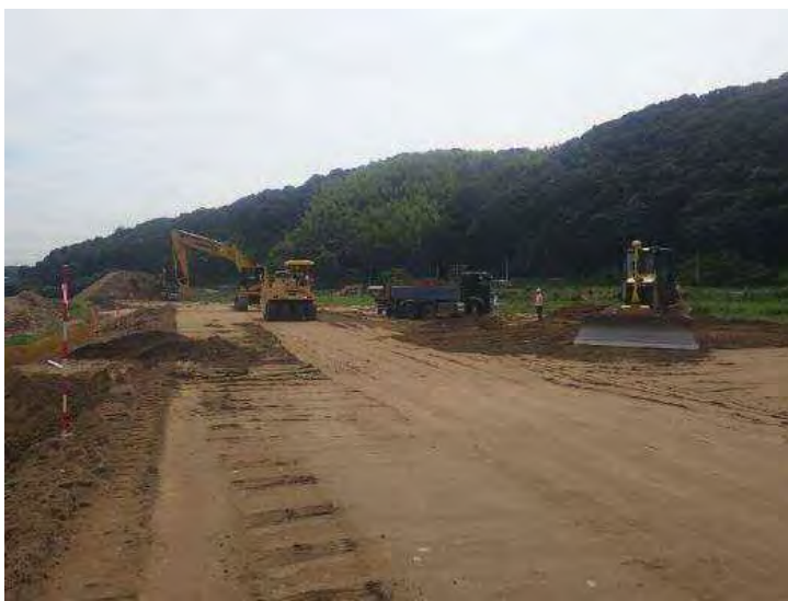
令和2年6月 耕作地堤防の築堤盛土
