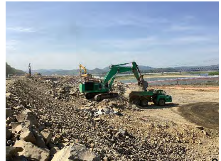
令和3年4月 南山の掘削
