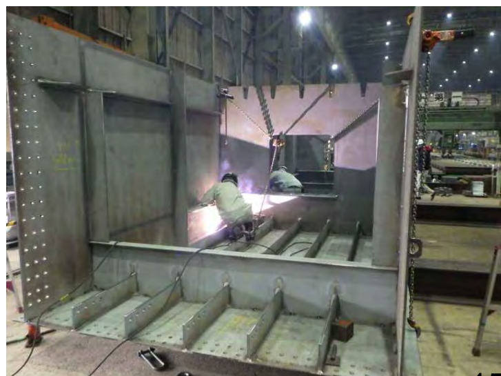
令和3年1月 橋桁製作
