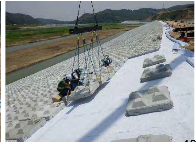
令和2年6月 締切堤防の護岸設置
