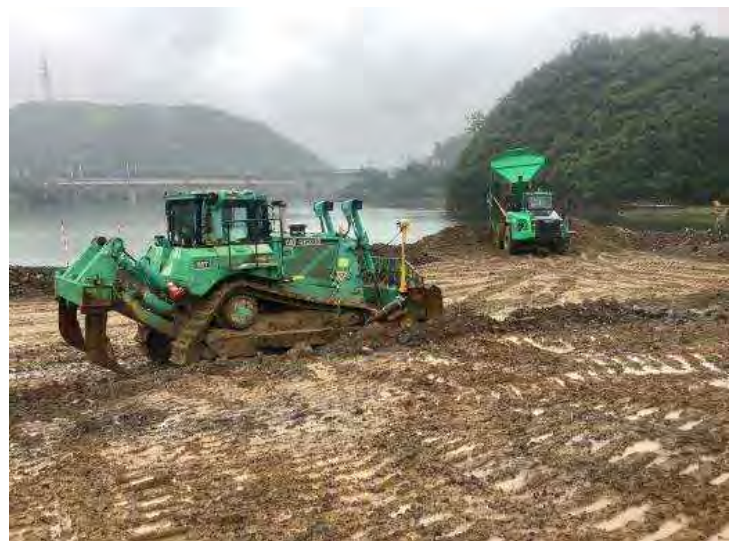
令和2年7月 柳井原地区堤防基盤整備
