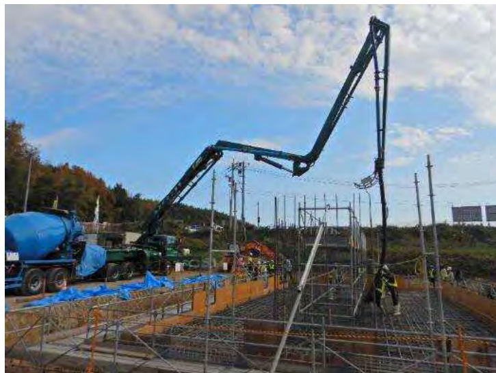
令和2年12月 橋台コンクリート工事
