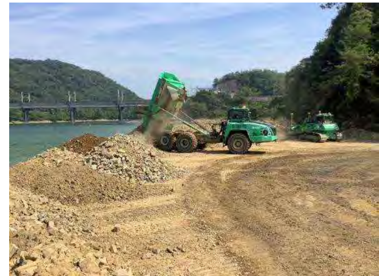
令和2年8月 柳井原地区堤防基盤整備
