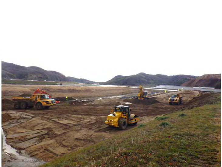
令和2年2月 締切堤防の盛土工事
