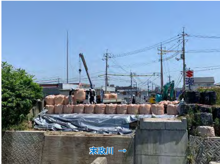
<陸閘閉鎖作業中>
