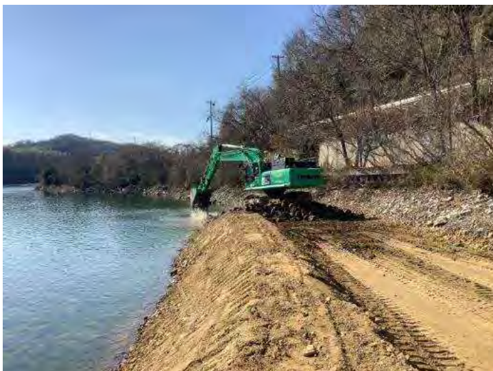
令和2年2月 柳井原地区堤防基盤の岩砕投入
