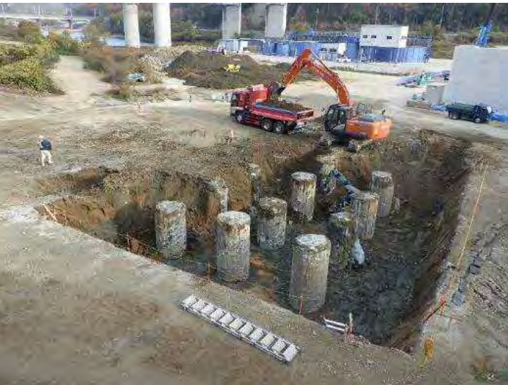
令和2年12月 橋台の基礎杭工事
