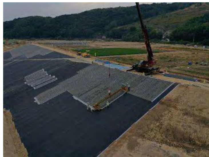
令和2年10月 耕作地堤防の護岸設置
