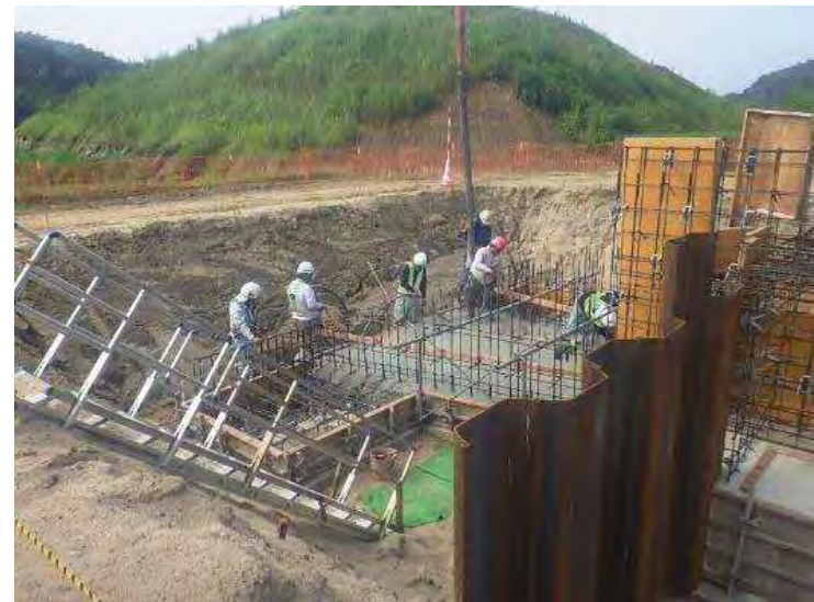
令和2年8月 排水樋門整備
