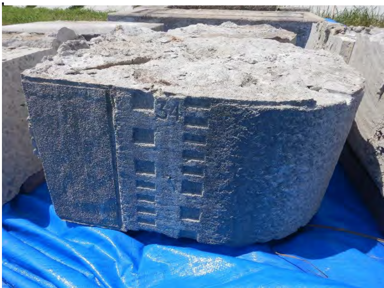
【量水標の切断状況：放水樋管】
