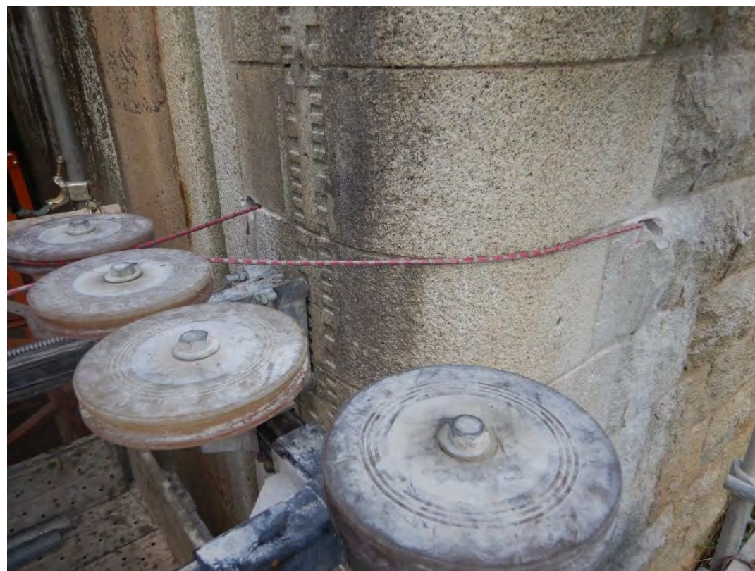
【ワイヤーソーによる石材の切断状況：放水樋管】
