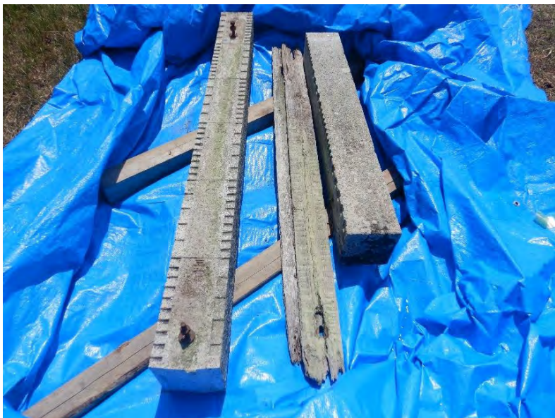
【量水標の切断状況：排水樋管】
