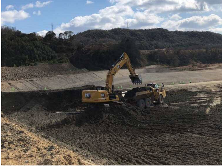
令和4年2月 酒津地区の掘削
