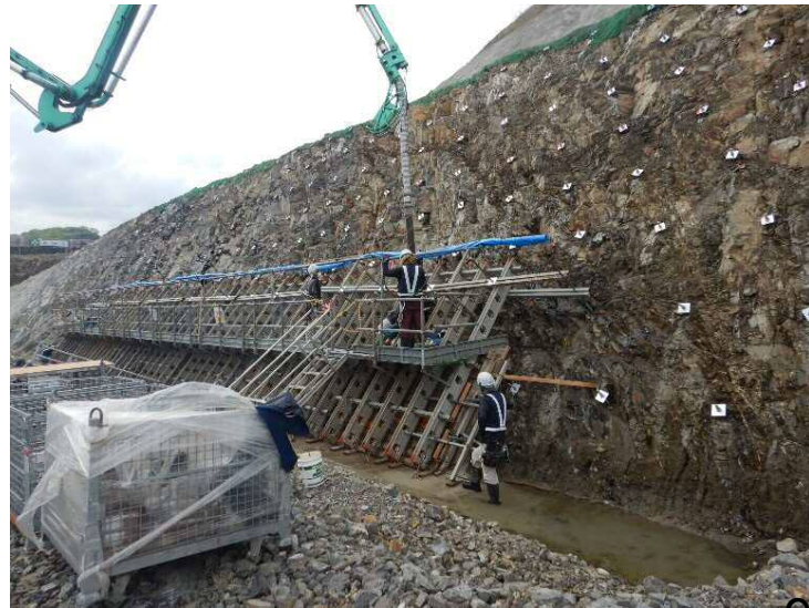
令和4年4月 南山法面保護
