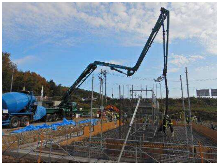
令和2年12月 橋台コンクリート工事
