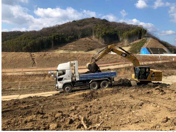
令和4年2月 酒津地区の掘削
