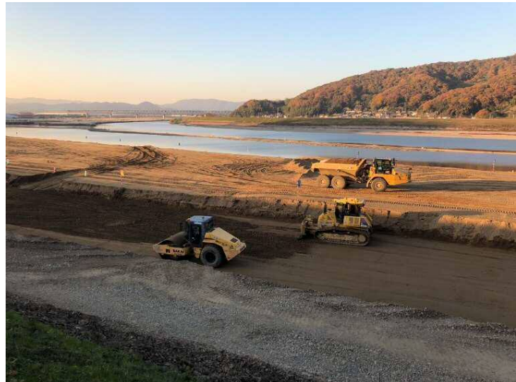
令和3年11月 締切堤防の盛土工事
