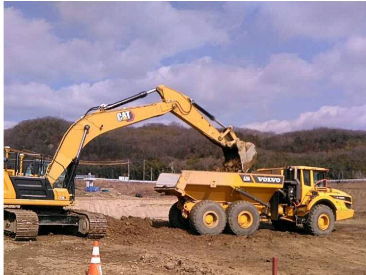
令和4年1月 新合流点の掘削
