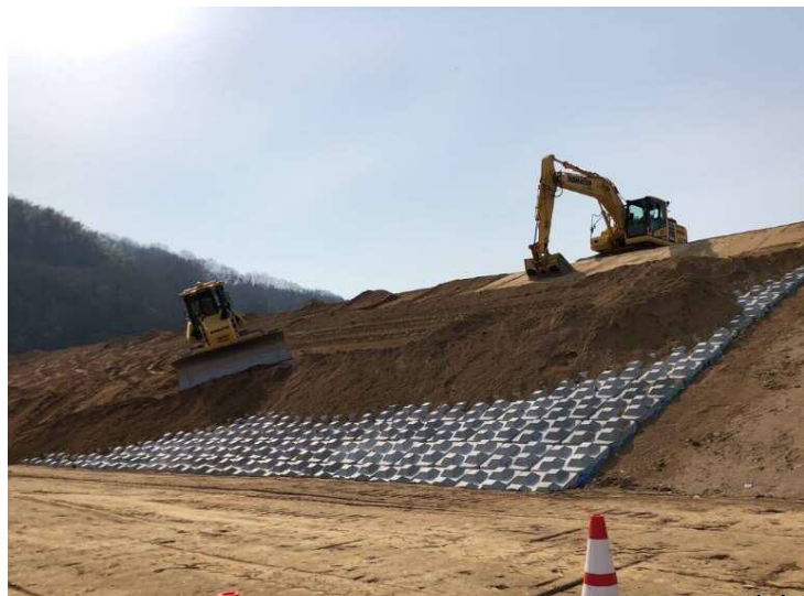
令和4年3月 締切堤防の堤防整備
