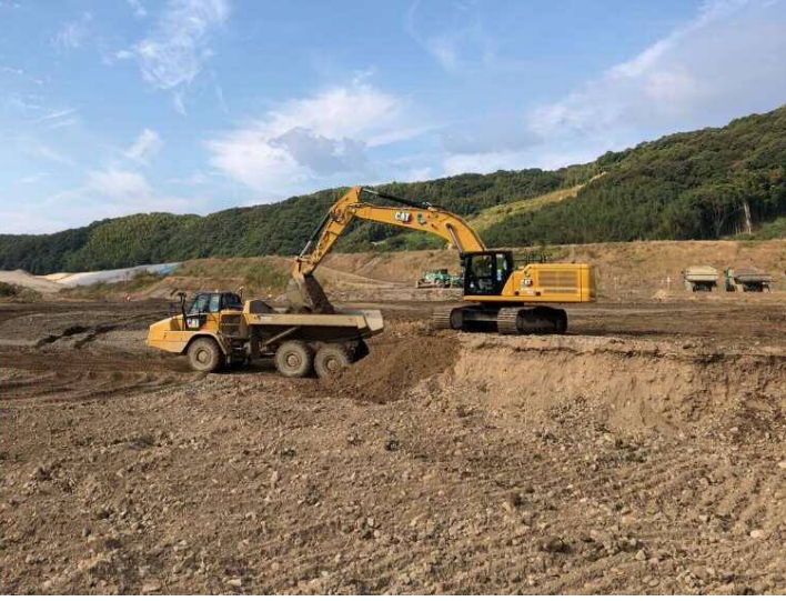
令和3年10月 酒津地区の掘削
