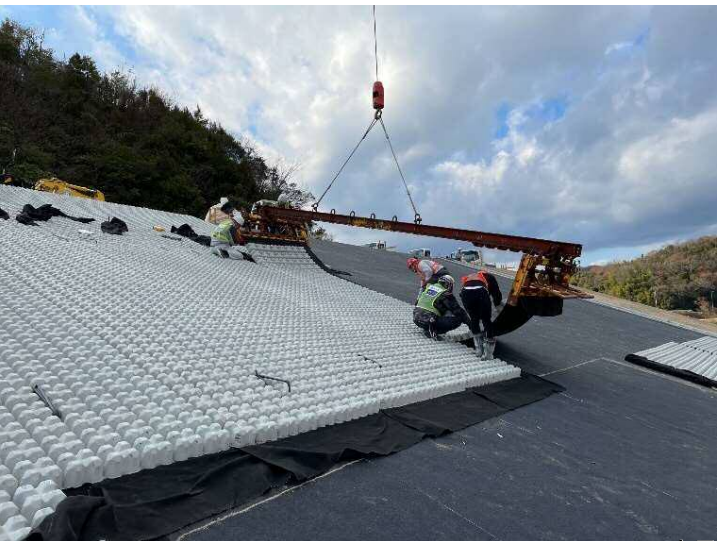
令和3年12月 柳井原地区護岸整備
