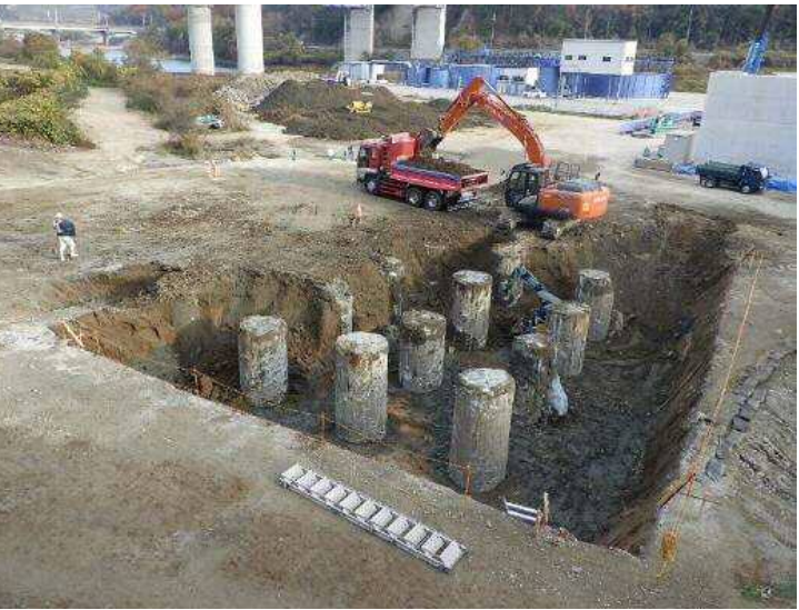
令和2年12月 橋台の基礎杭工事
