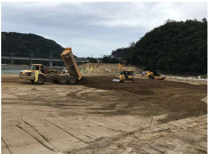
令和3年9月 柳井原地区堤防整備
