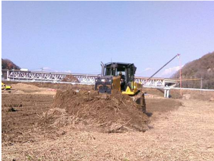
令和3年12月 新合流点の掘削
