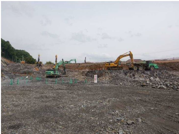
令和4年4月 南山の掘削
