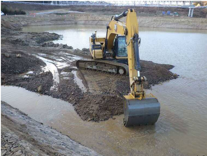
令和4年2月 新合流点の掘削
