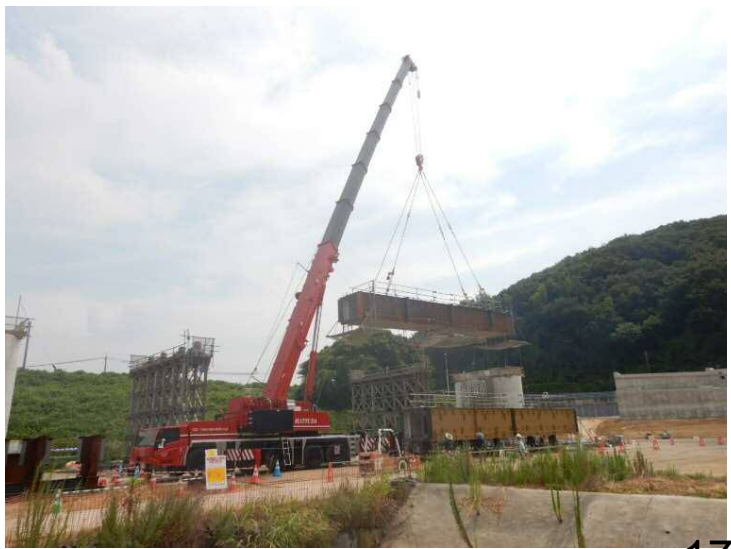
令和3年8月 橋桁の架設
