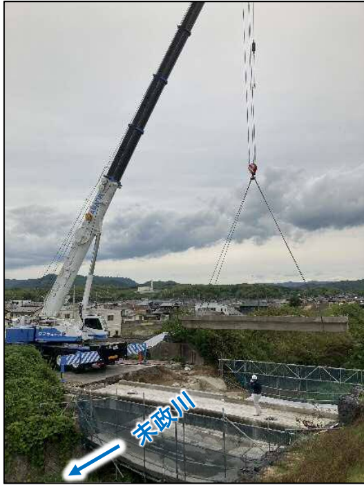
(1) 既設橋梁 撤去
