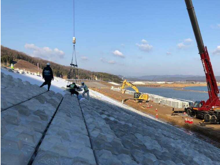
令和4年2月 締切堤防の護岸整備
