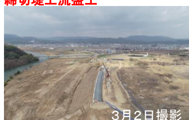
締切堤上流盛土
