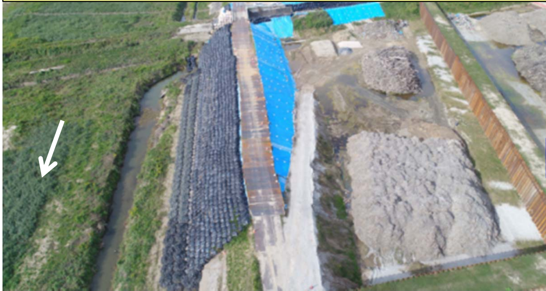
平成30年10月30日 本復旧工事に着手
