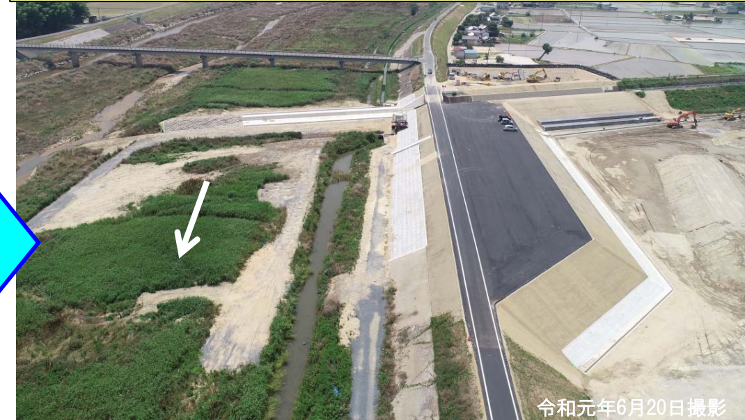
本堤防の復旧完了
