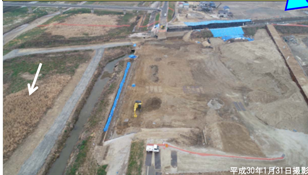
荒締切堤防（仮設堤防）の撤去完了
