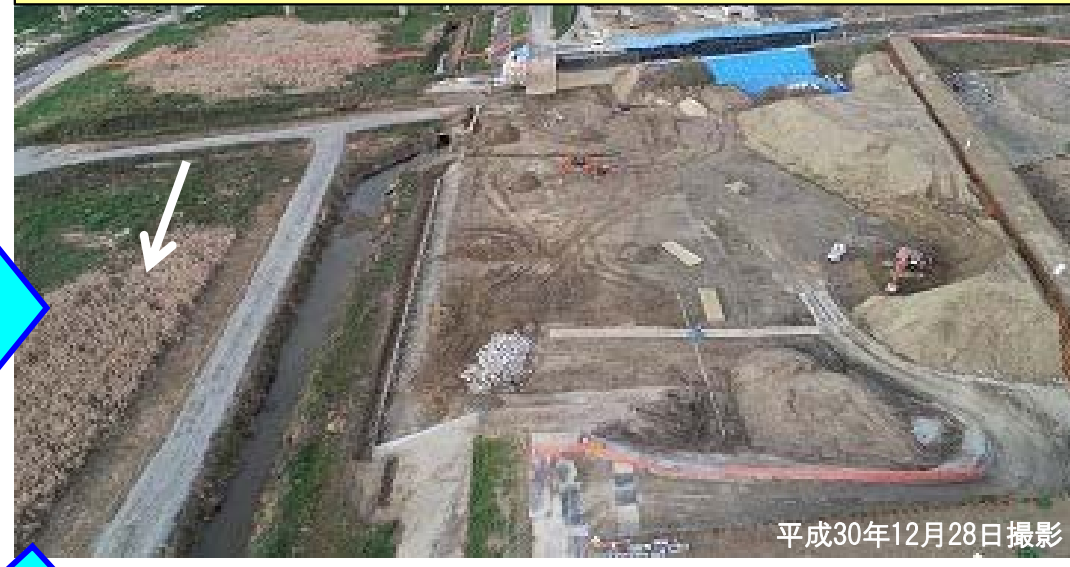
荒締切堤防（仮設堤防）の撤去作業中
