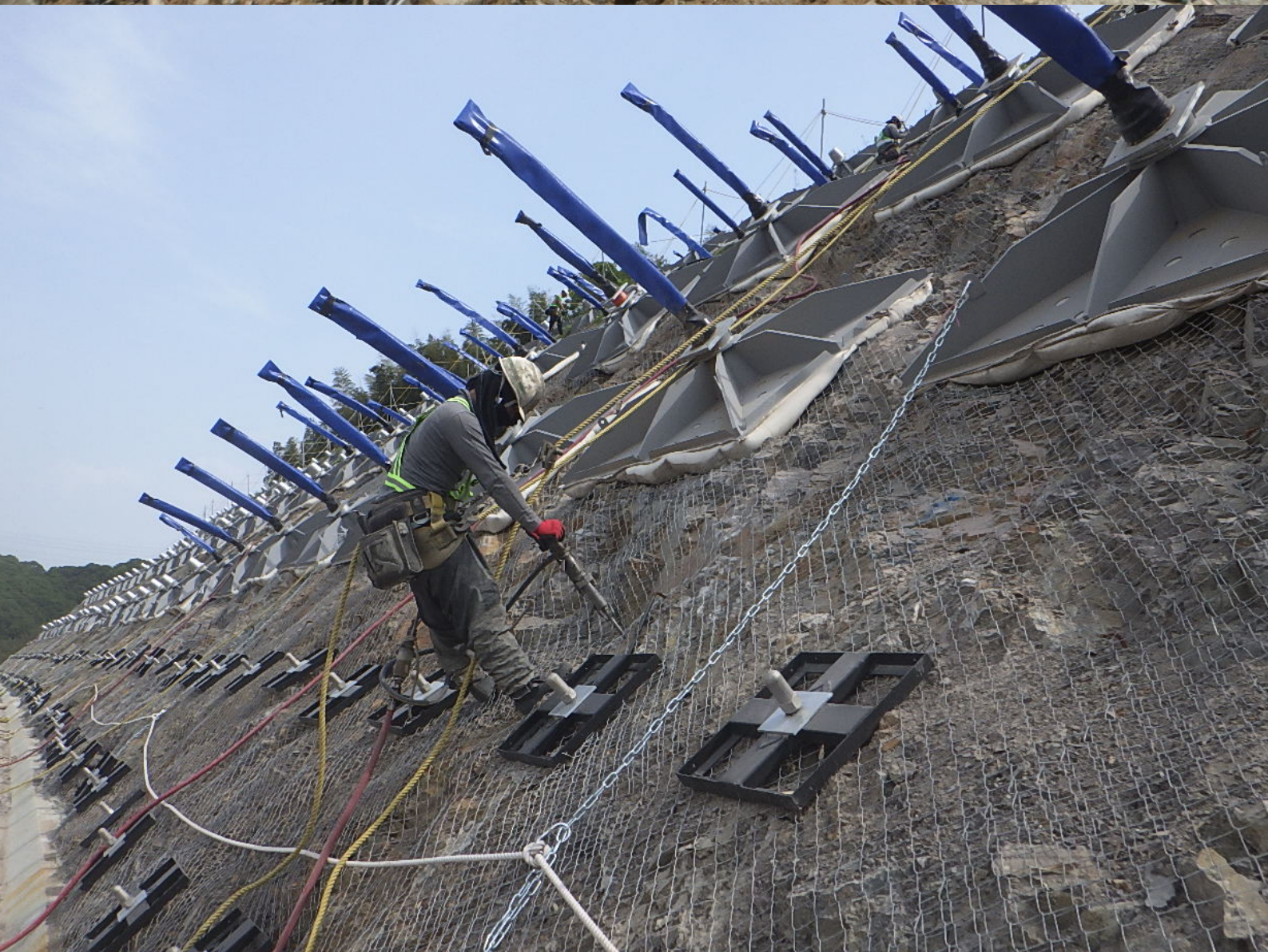
南山の法面を強化するためのコンクリート吹き付け
