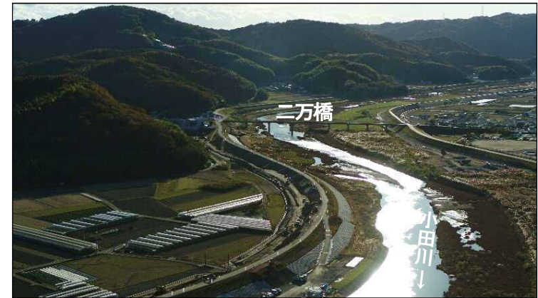
②堤防強化区間(下流より望む)
