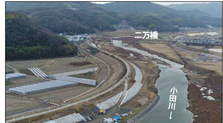
②堤防強化区間(下流より望む)
