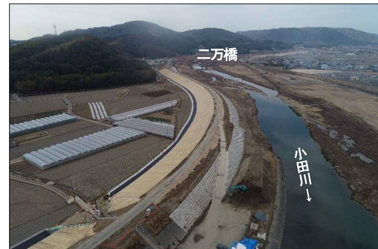
②堤防強化区間(下流より望む)
