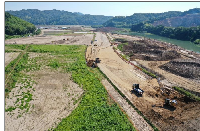
②貯水池下流から見た堤防
