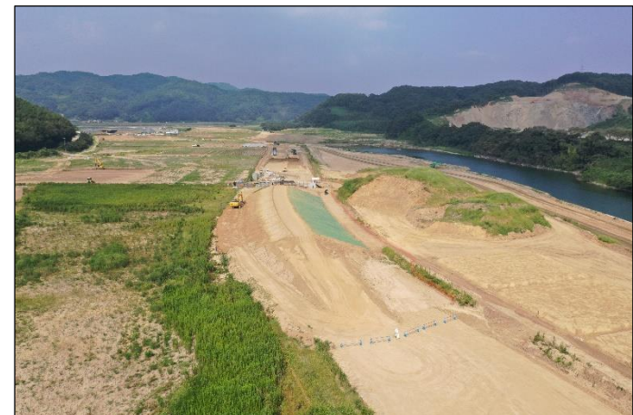
②貯水池下流から見た堤防
