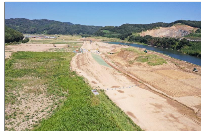
②貯水池下流から見た堤防
