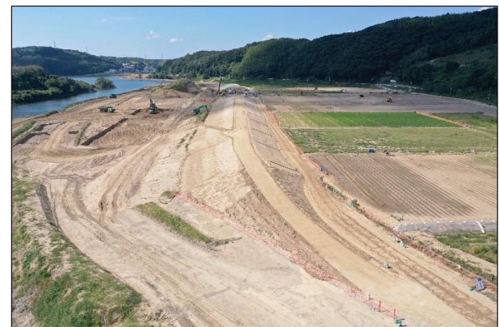
②貯水池下流から見た堤防
