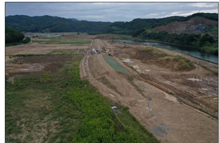
②貯水池下流から見た堤防
