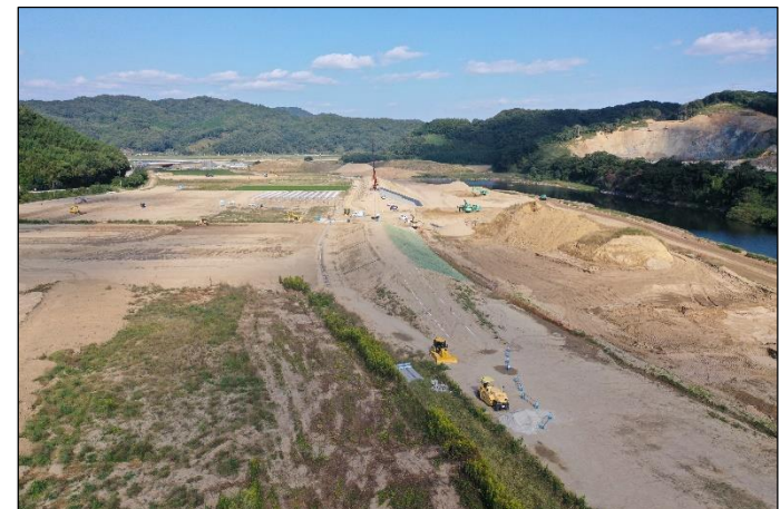
②貯水池下流から見た堤防
