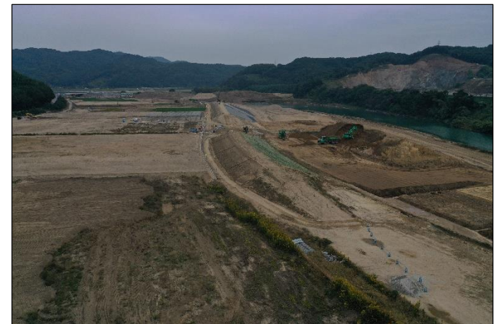
②貯水池下流から見た堤防
