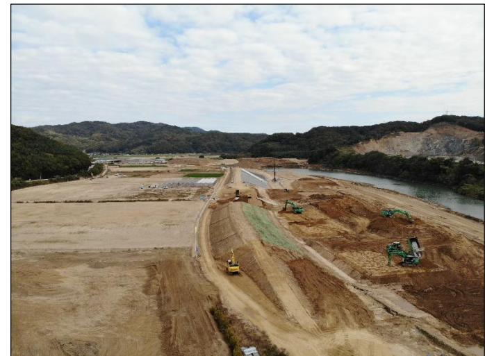
②貯水池下流から見た堤防
