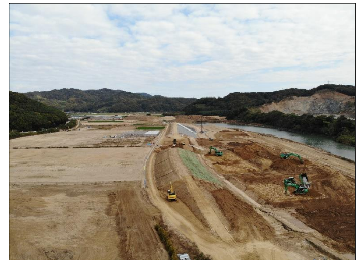
②貯水池下流から見た堤防
