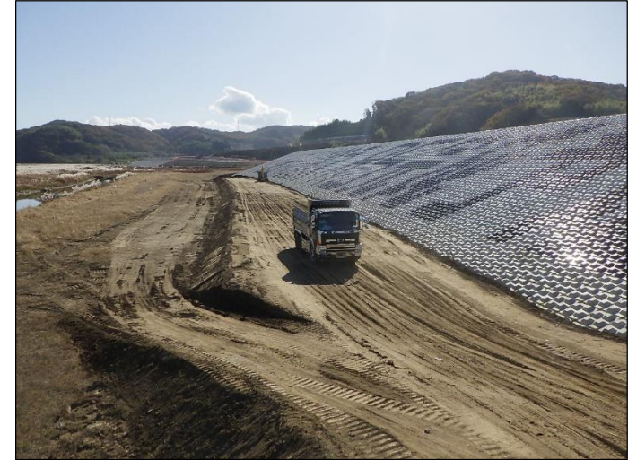
現地作業状況
