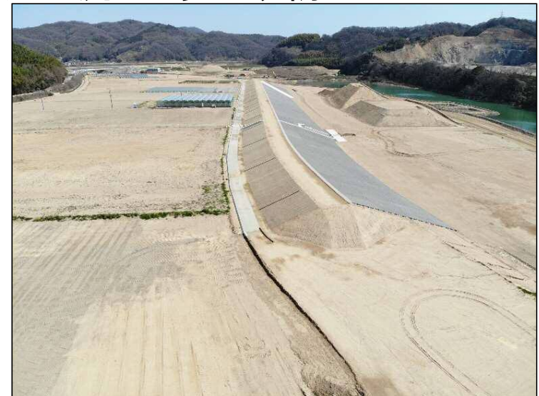
②貯水池下流から見た堤防
