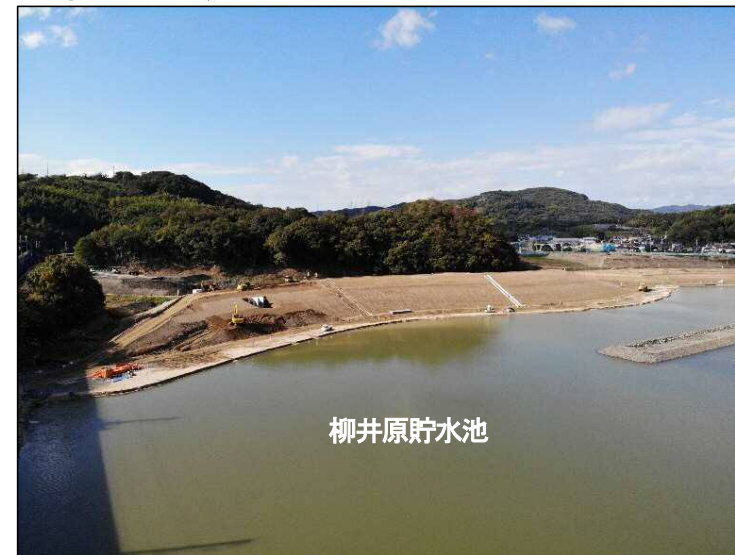
①築堤区間(下流より望む)
