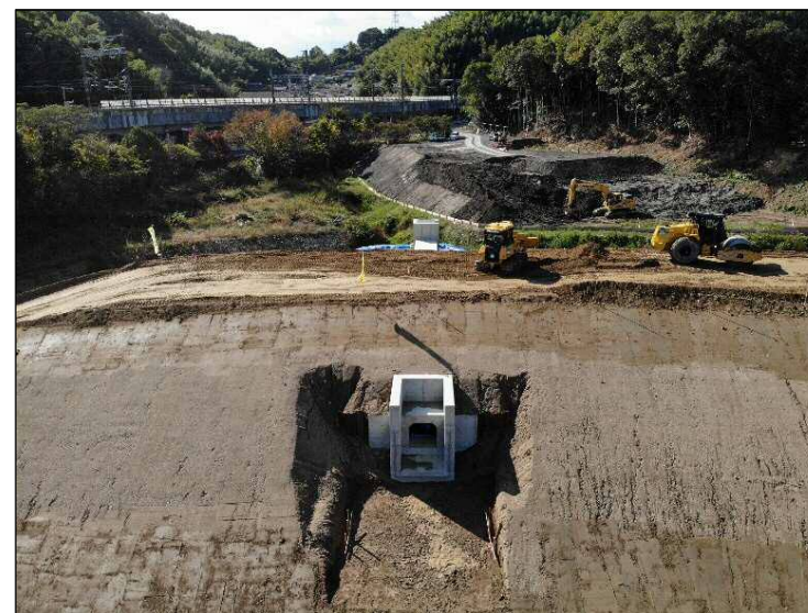
③排水樋門
