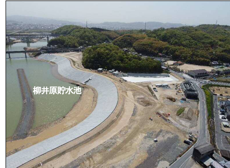
①築堤区間(上流より望む)
