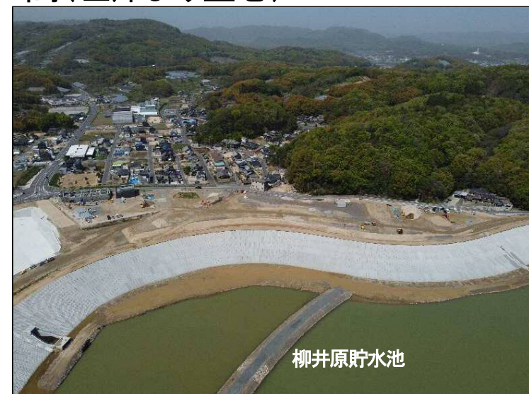
③築堤区間(左岸より望む)
