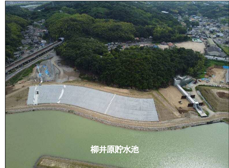
①施工区間(貯水池より望む)
