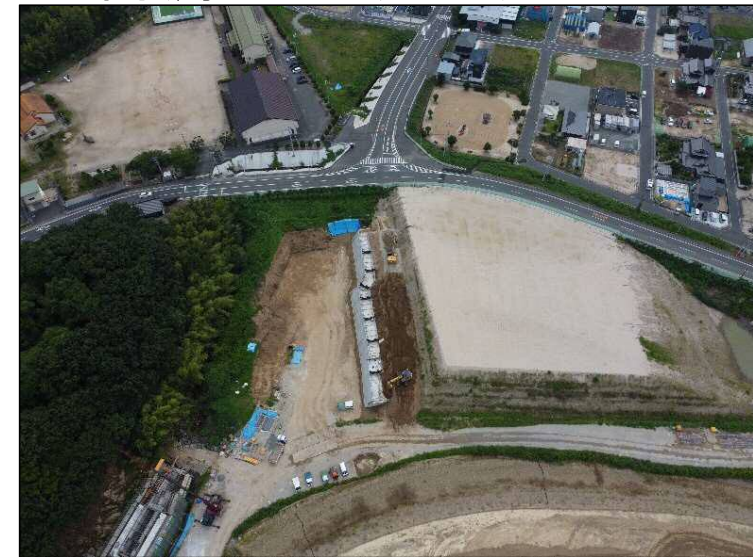
③遊水池区間(貯水池より望む)
