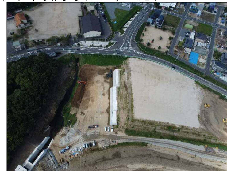
③遊水池区間(貯水池より望む)
