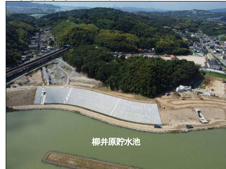
①施工区間(貯水池より望む)
