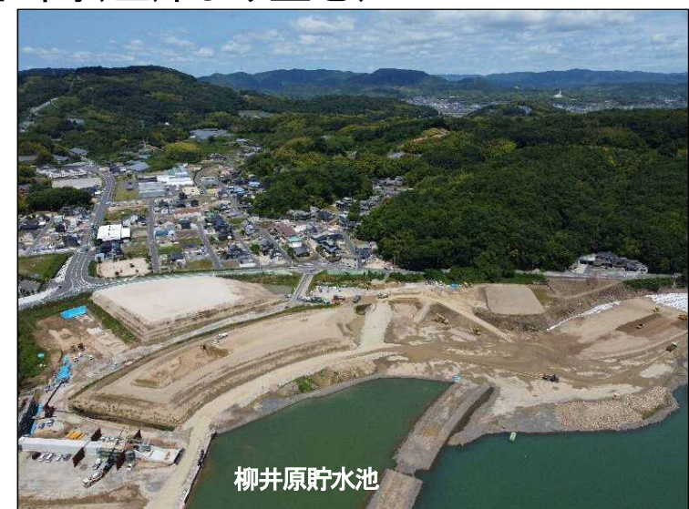
③築堤区間(左岸より望む)
