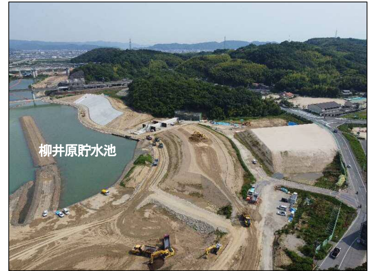
①築堤区間(上流より望む)
