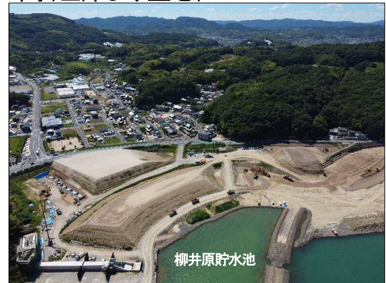
③築堤区間(左岸より望む)
