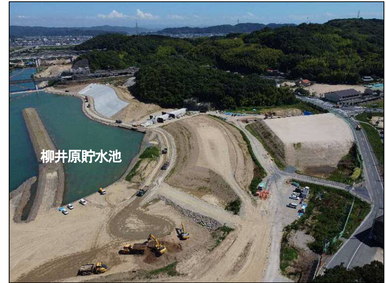
①築堤区間(上流より望む)
