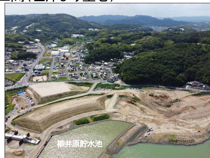
③築堤区間(左岸より望む)
