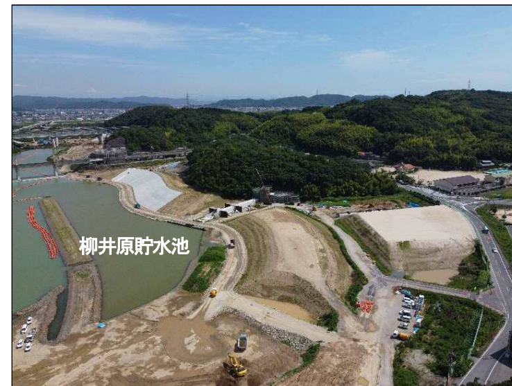
①築堤区間(上流より望む)
