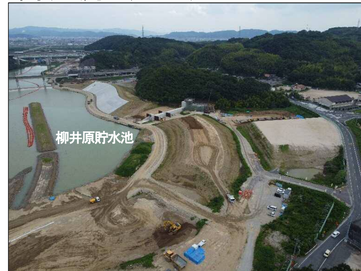
①築堤区間(上流より望む)
