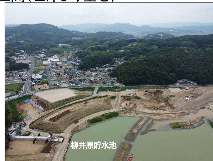
③築堤区間(左岸より望む)
