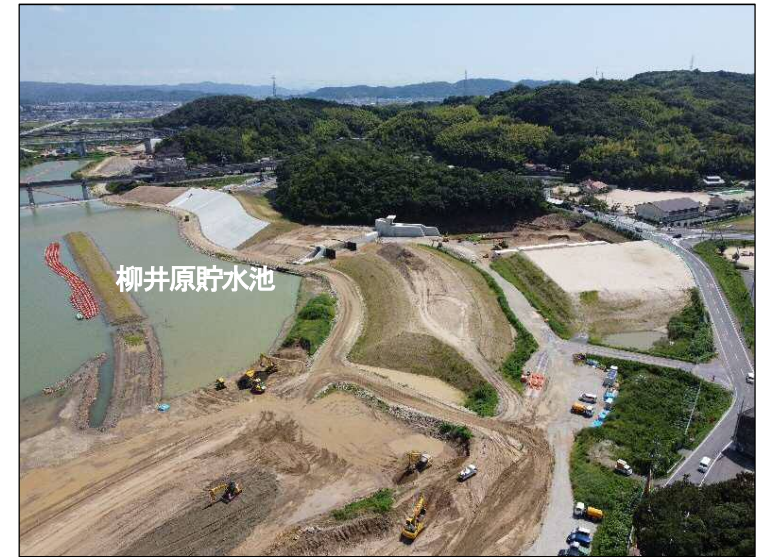
①築堤区間(上流より望む)
