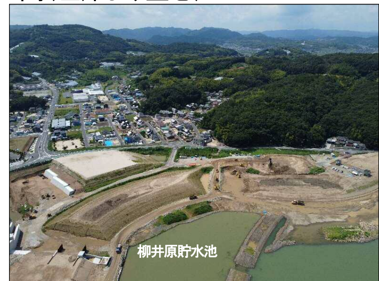
③築堤区間(左岸より望む)
