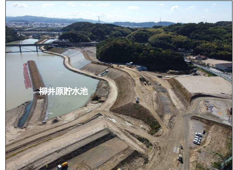
①築堤区間(上流より望む)
