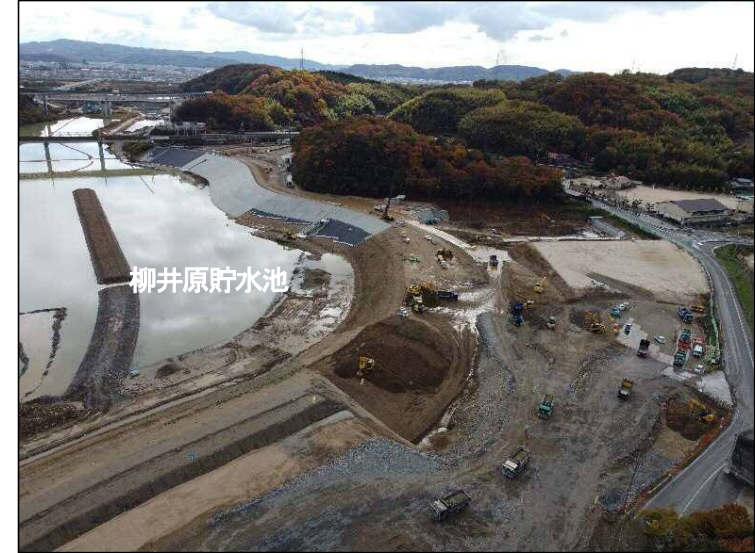
①築堤区間(上流より望む)
