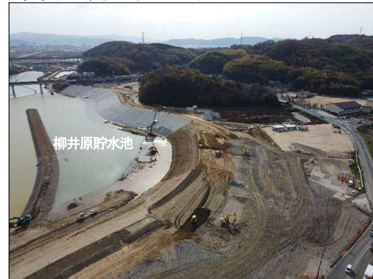
①築堤区間(上流より望む)
