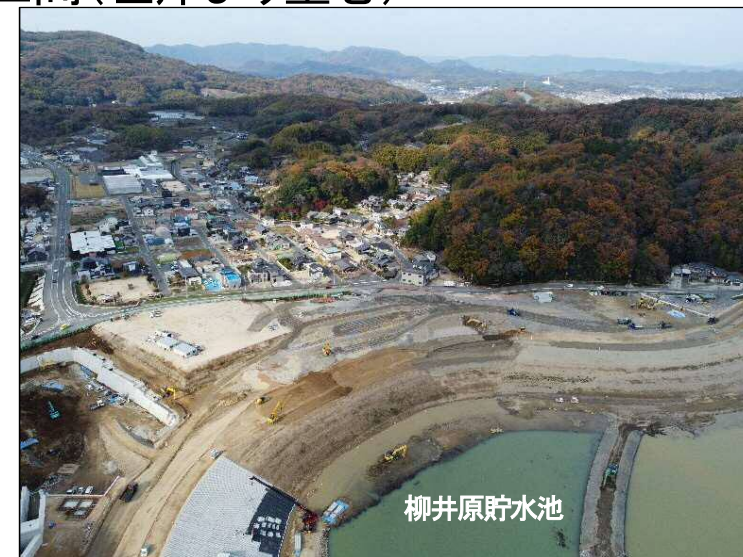
③築堤区間(左岸より望む)
