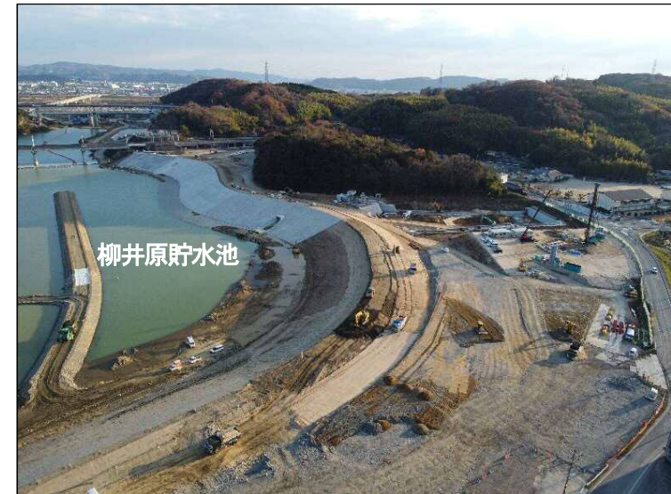
①築堤区間(上流より望む)
