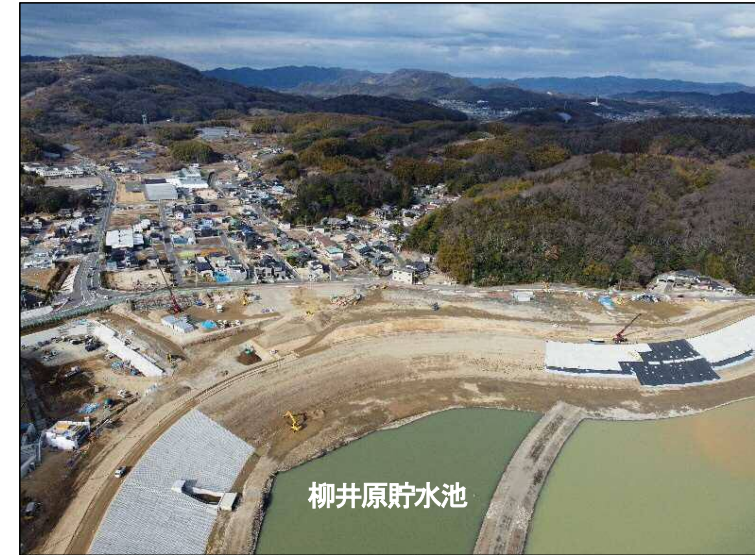
③築堤区間(左岸より望む)
