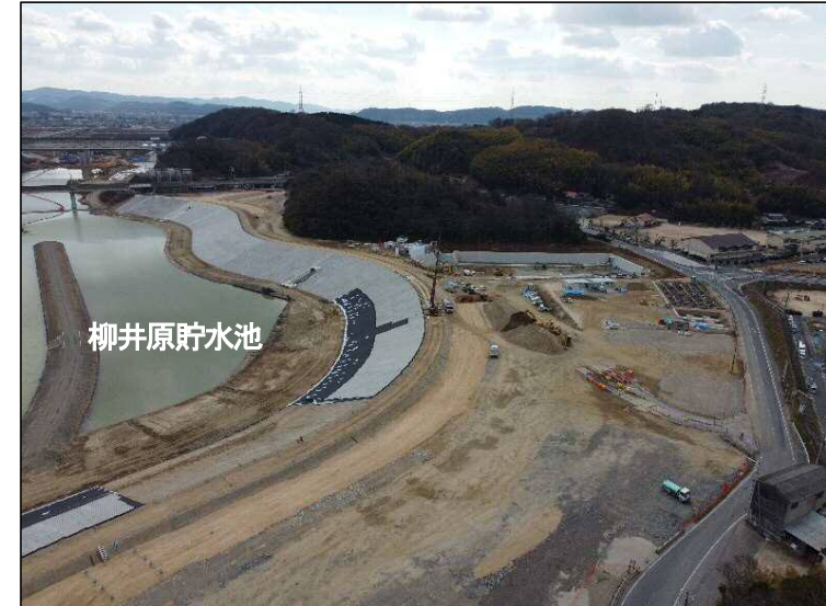
①築堤区間(上流より望む)
