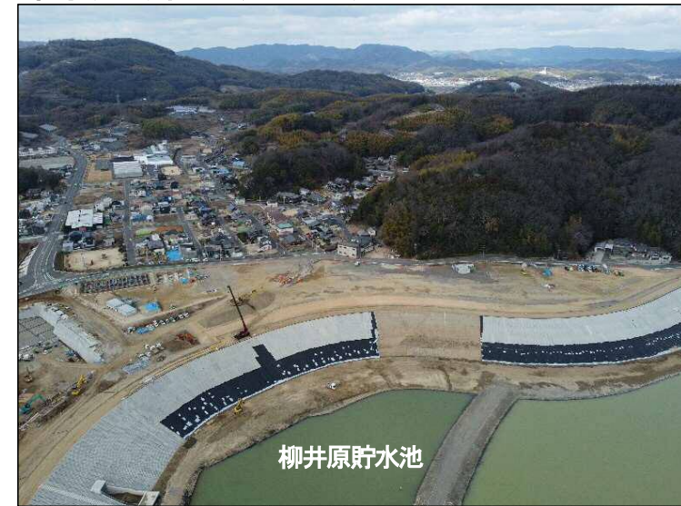
③築堤区間(左岸より望む)
