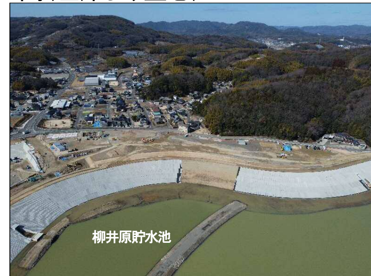
③築堤区間(左岸より望む)
