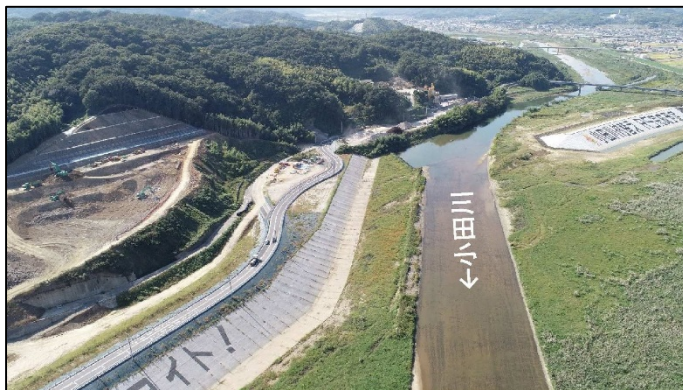
①小田川下流から見た県道迂回路、上流締切堤防
