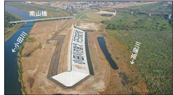
③高梁川から見た上流締切堤防
