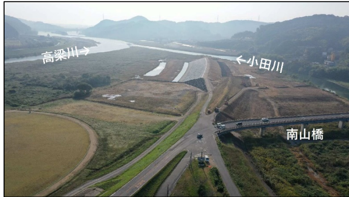
②小田川上流から見た上流締切堤防
