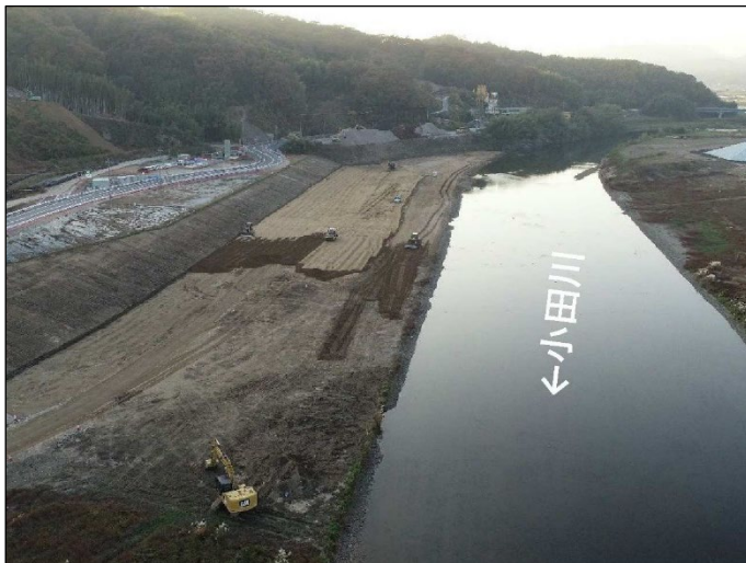
①小田川下流から見た県道迂回路、上流締切堤防
