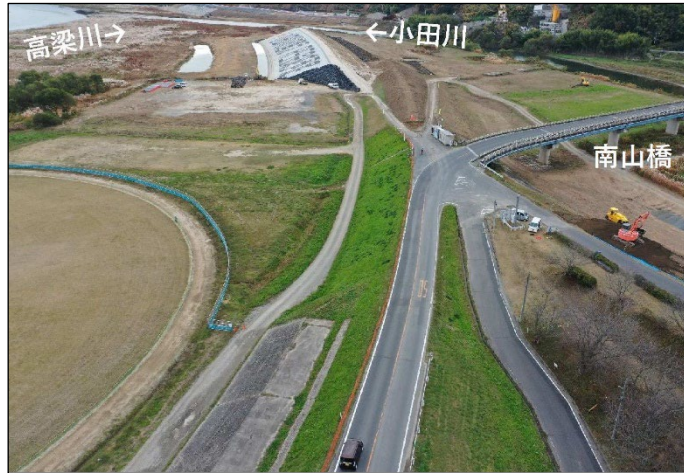
②小田川上流から見た上流締切堤防
