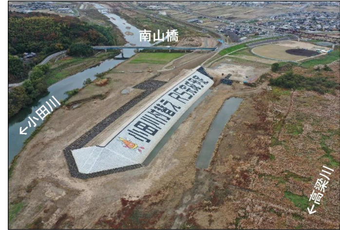
③高梁川から見た上流締切堤防
