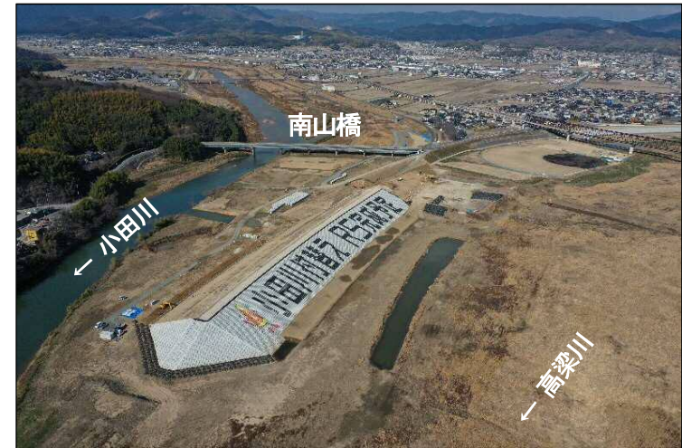
③高梁川から見た上流締切堤防
