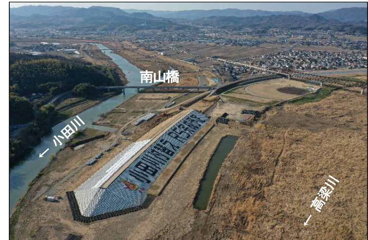
③高梁川から見た上流締切堤防
