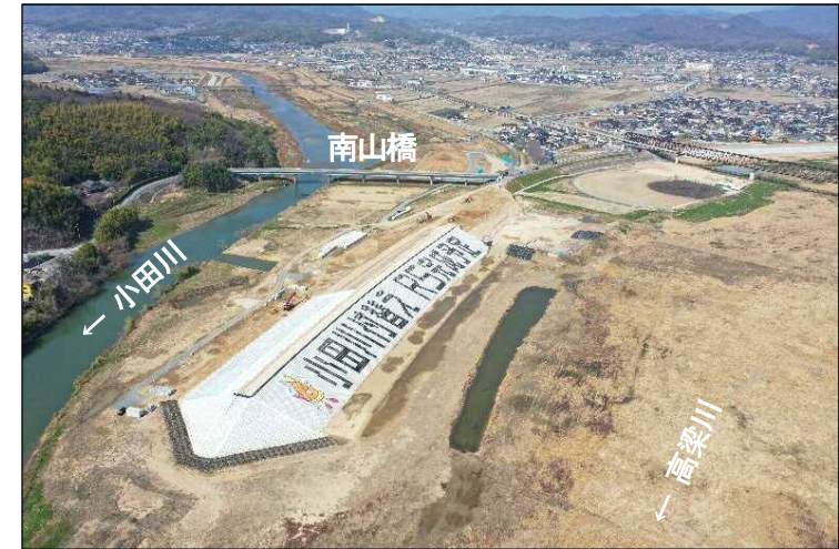
③高梁川から見た上流締切堤防
