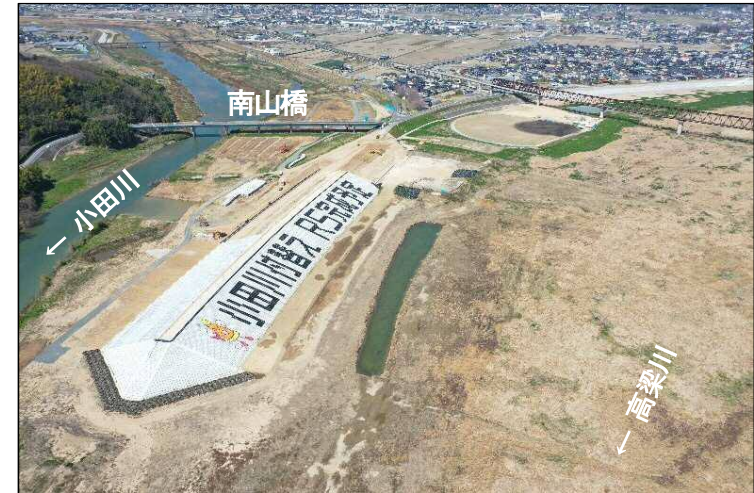
③高梁川から見た上流締切堤防
