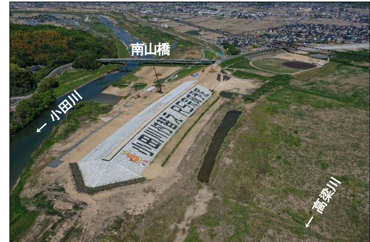
③高梁川から見た上流締切堤防
